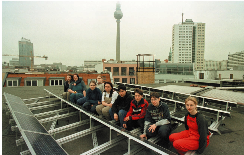
Foto: Die Auszubildenden vor der Photovoltaikanlage auf dem Dach der Ausbildungswerkstatt, die sie selbst installiert haben.
